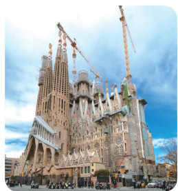
▲ 공사 중인 사그라다 파밀리아 성당
