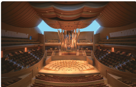
▲ 천장과 벽면에 반사판을 설치한 음악당
