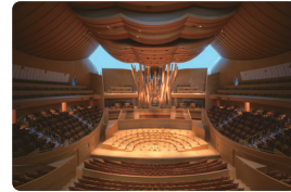
▲ 천장과 벽면에 반사판을 설치한 음악당
